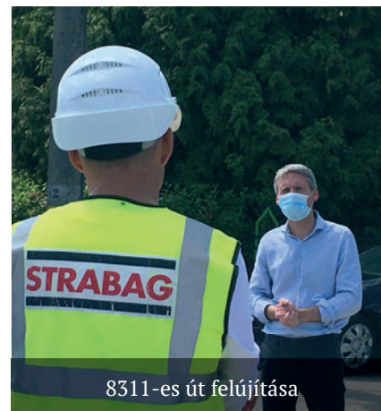
8311-es út felújítása
