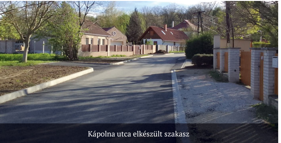
Potyondi út gázvezeték miatt elmaradt részének aszfaltozása
