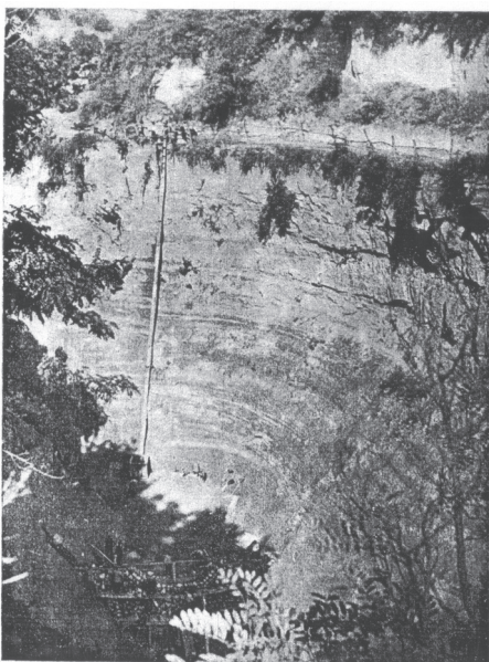
4. kép. A IX. sz. gát építése anyagszúzával.
